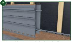
Stellen Sie sicher, dass der Verbinder bis zum Anschlag eingeschoben ist und fixieren Sie diesen mit Hilfe der beigefügten Schraube seitlich durch den vorhandenen Schraubkanal.
