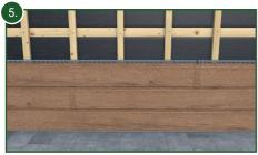
Die Position der Stoßverbindung kann sowohl zwischen 2 Holzlatten (siehe Bild) als auch auf einer Holzlatte (siehe Bild 4) erfolgen.
