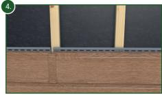
Die Position der Stoßverbindung kann sowohl auf einer Holzlatte (siehe Bild) als auch zwischen 2 Holzlatten (siehe Bild 5) erfolgen.
