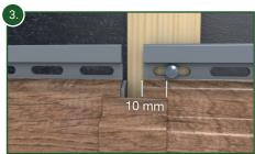
Fügen Sie nun die Fassadenprofile zusammen. Stellen Sie sicher, dass die Profile gemäß den Angaben der Montageanleitung mittig durch eine Schraube **zwischen 2 Langlöchem** fixiert sind. Die Breite der Dehnfuge muss 10 mm betragen (siehe Bild).
