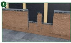
Schieben Sie den Stoßverbinder am rechten Ende des Fassadenprofils seitlich in die Kammern ein.
